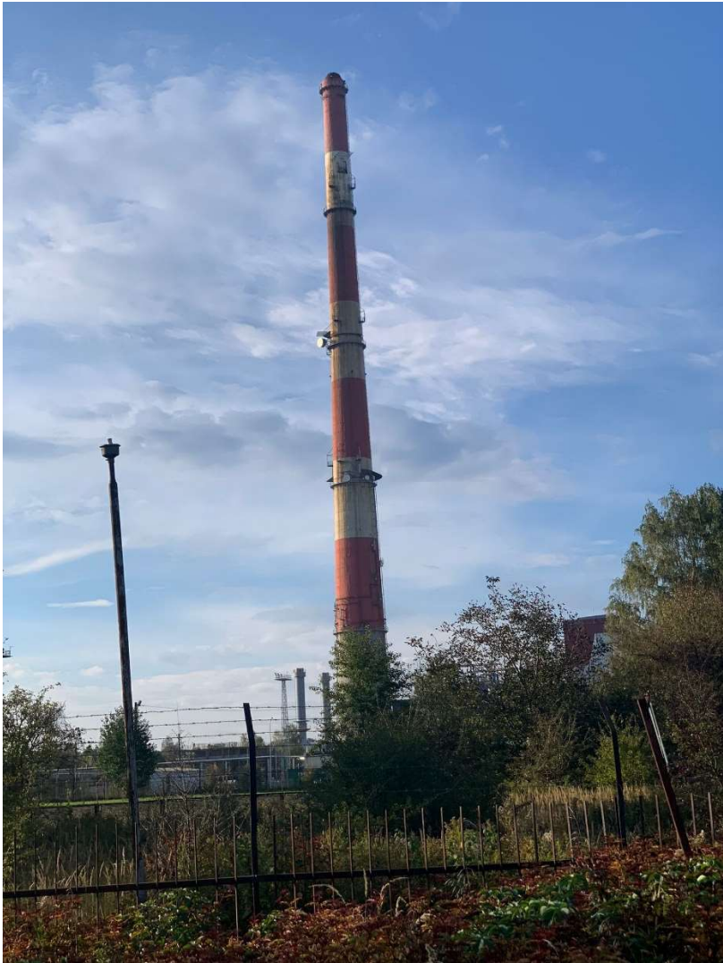
Zdjęcie 1 Badany obiekt
